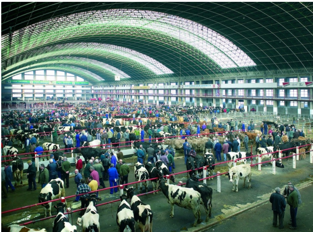
Fig. 2.2: Instante tomado durante la celebración de una de las ferias de ganado y perspectiva de la bóveda espacial y de los pórticos, transversales a la nave principal, que recogen los empujes horizontales de la cubierta.
