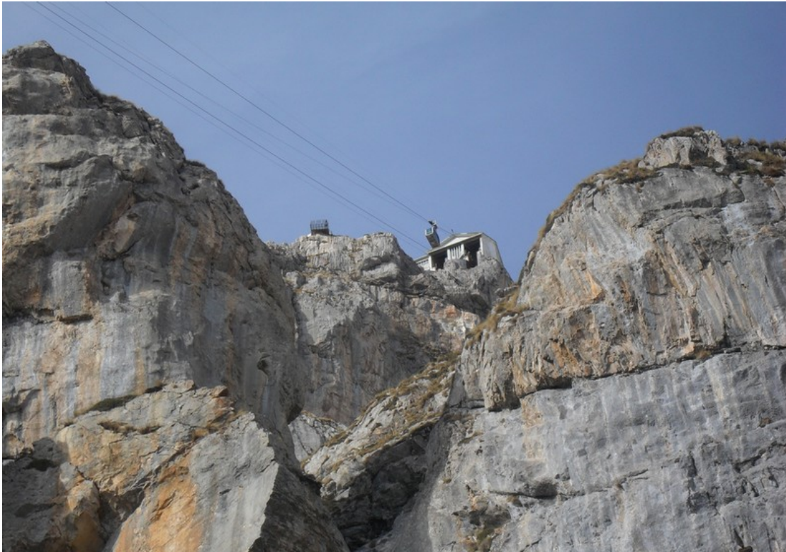
Fig. 1.2: Estación superior, a 1820 m. de altitud, del Teleférico.
