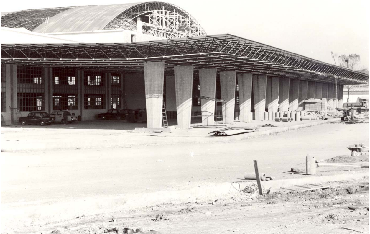
Fig. 2.18: Fotografía de la época, una vez finalizada la construcción de la marquesina del Mercado Nacional de Ganados de Torrelavega.
