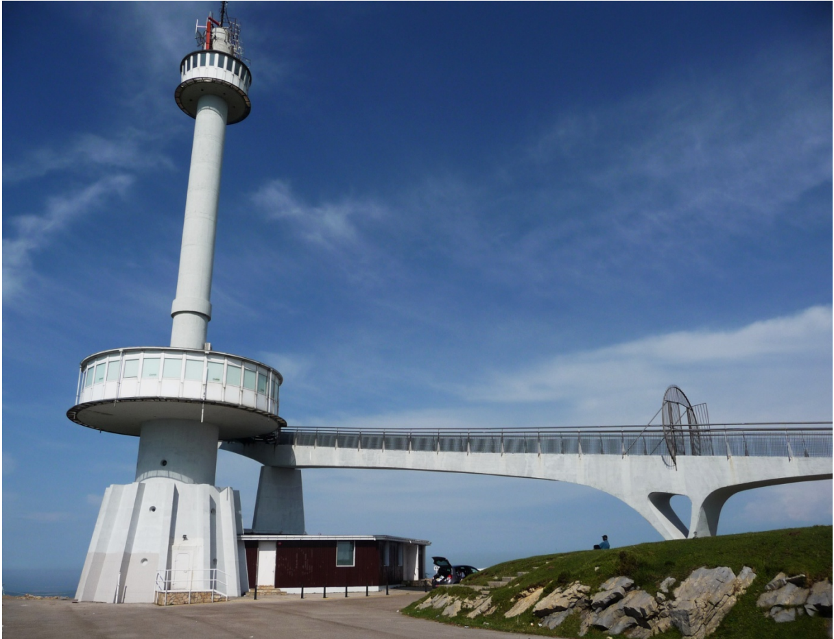
Fig. 3.2: Vista de los elementos principales del monumento.
