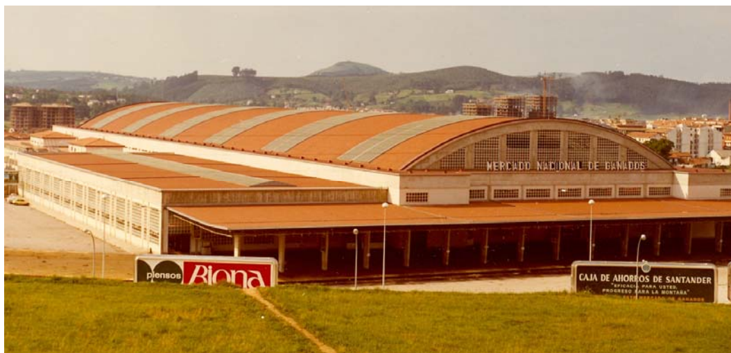
Fig.2.1: Perspectiva general de la obra terminada.
